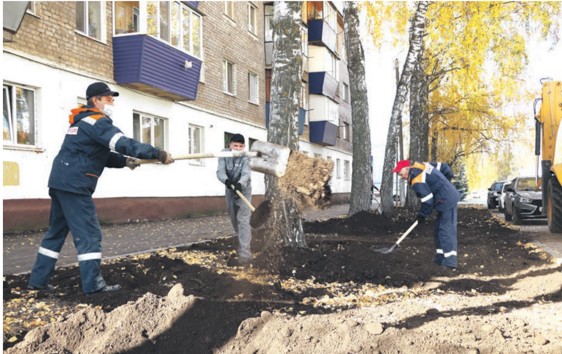
На фото: работники управления «Геосервис» благоустраивают газоны возле главного здания компании
